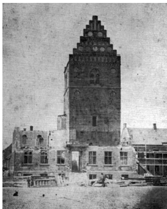
Nedrivningen af det gamle rådhus år 1883.
