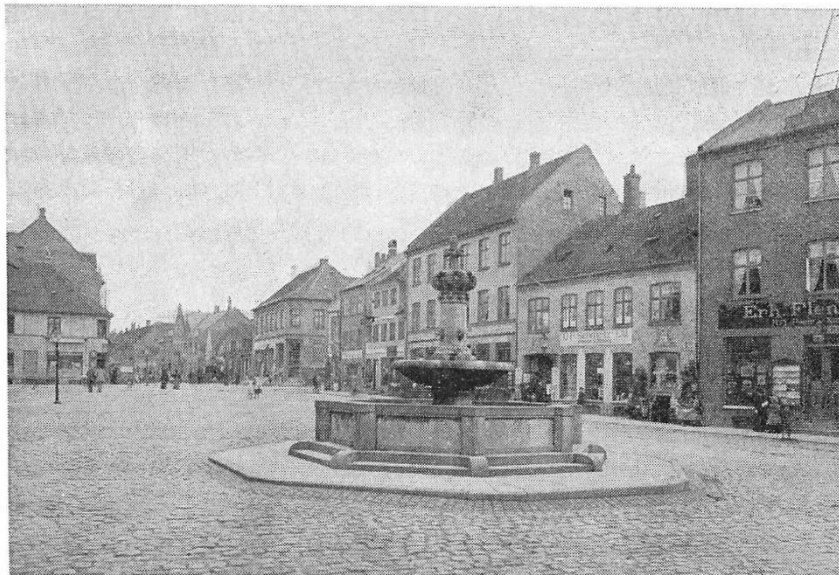
Rådhusstorvet. Bag springvandet Schmeltz' ejendom, nr. 6. Hans »private« vindue er oven over nedgangen til træhandelen.
