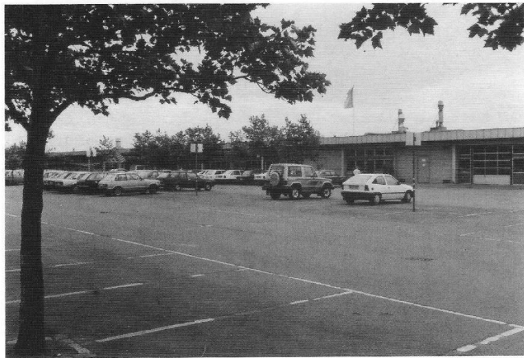
Roskilde tekniske Skole's nuværende bygninger - Maglelunden 2.
