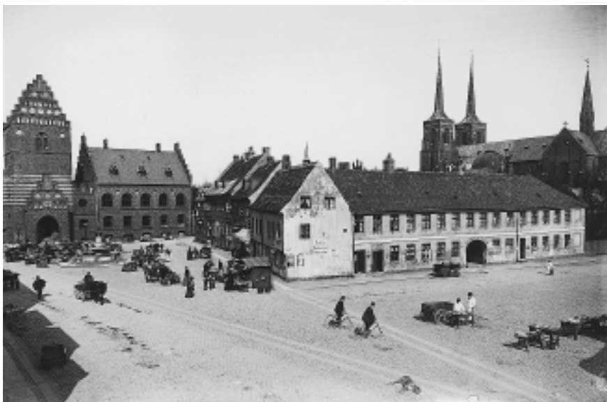
Fig. 2. Torvet som det så ud før nedrivningen i 1908 af karréen midt i billedet. Foran rådhuset lå det trekantede torv, Rådhusetorvet, og til højre derfor det lille Nytorv, der stødte op til Det Kongelige Palæ. I 1921 fik Nytorv navneforandring til Stændertorvet til minde om stænderforsamlingerne, der var blevet holdt på palæet. Navnet Stændertorvet kom først i 1954 til at dække hele det store torveområde. Foto Kr. Hude. Roskilde Museum.
