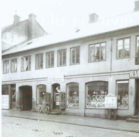
Den gamle facade med Chr. Winters navn på bygningen
